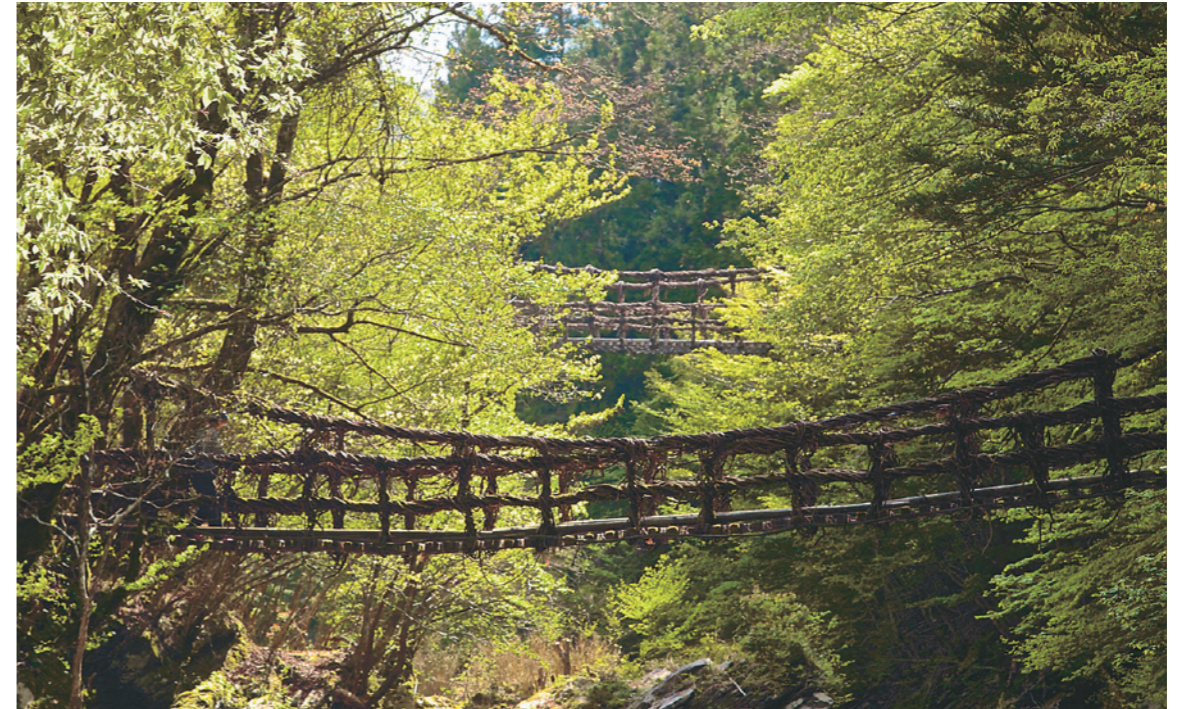
三好市の奥祖谷にある、祖谷川にかかる吊り橋。男橋と女橋の2本が並んでかかっている。
