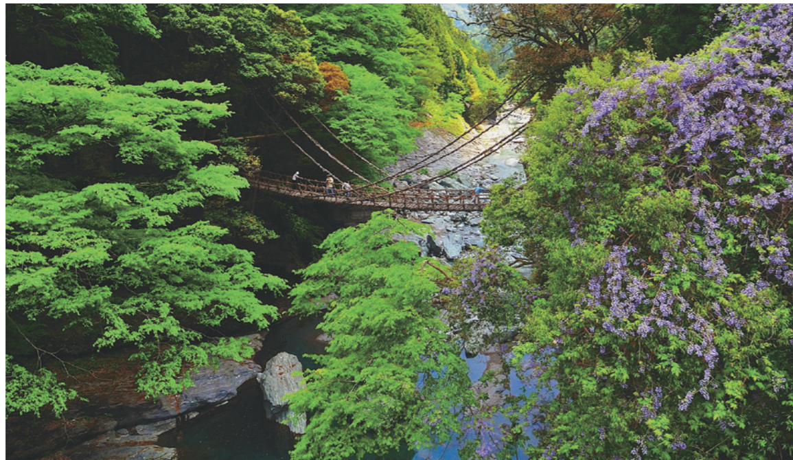
三好市西祖谷山村にある、自然のカズラを使って作った吊り橋。日本でとてもめずらしい3つの橋のひとつ。
